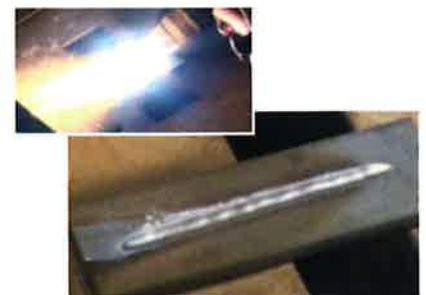
エアプラズマ ガウジング 施工例
